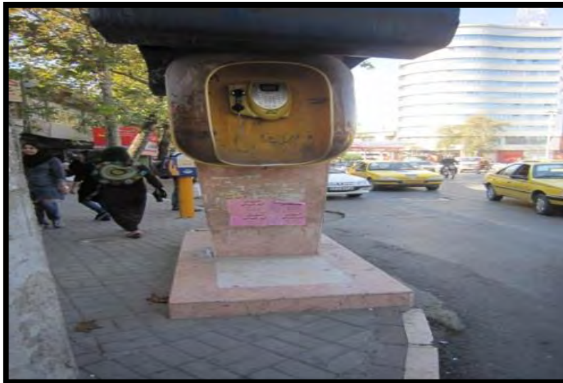
شکل (۴): عدم رعایت ارتفاع استاندارد و تعبیه سکو در پای کیوسک تلفن، ابتدای خیابان ولیعصر
