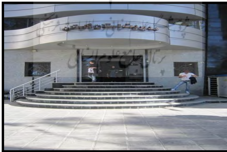
شکل (۶): عدم وجود رمپ در ورودی ساختمان مدیریت استان گلستان،
