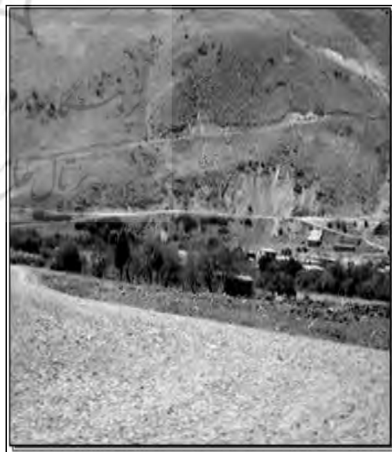
شکل ۲. پدیده لغزش در دامنه‌های شهر سنقر
