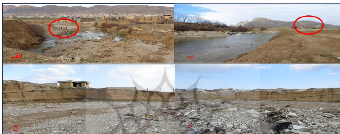
شکل (۳): (الف) برداشت غیر مجاز شن و ماسه از بستر رودخانه، (ب) معدن برداشت شن و ماسه، (ج) فرسایش کناره ای رودخانه، (د) اشغال دشت سیلابی در بخش اول رودخانه خرم رود
