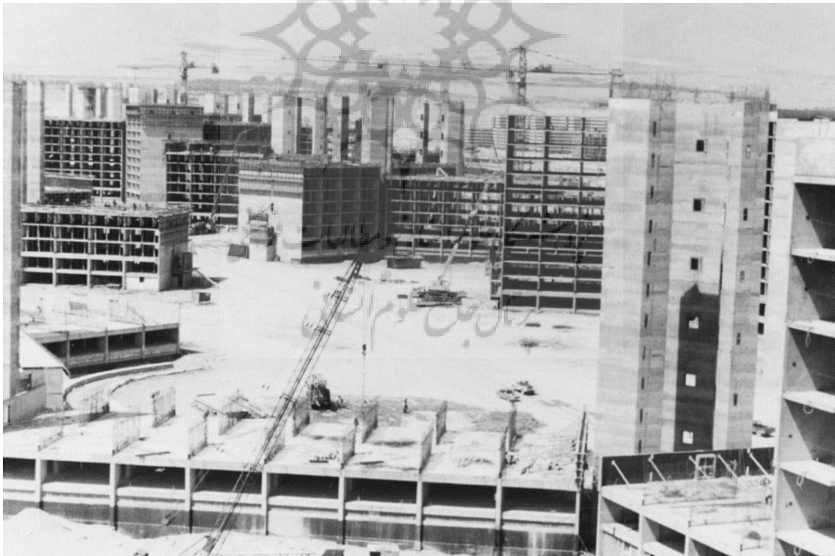
تصویر ۱: فاز یک شهرک اکباتان در حال ساخت، مأخذ: https://www.hamshahrionline.ir
