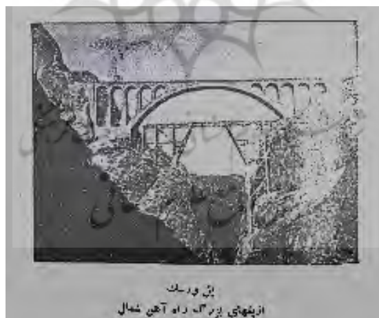
پل ورسک (تصویر-۶): پل ورسک (وزارت فرهنگ، ۱۳۱۹: ۱۸۵)
