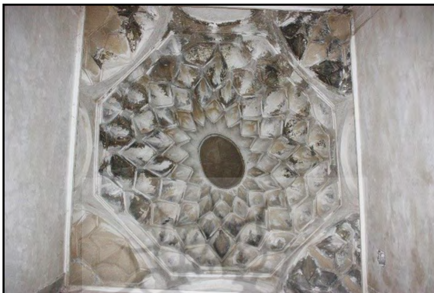
شکل ۱۰: نمایی از بخش درونی گنبدخانه و تزیینات زیر گنبد «مُضَرَّس» (مسعودی‌نیا، ۱۳۹۹: ۱۱۹)
