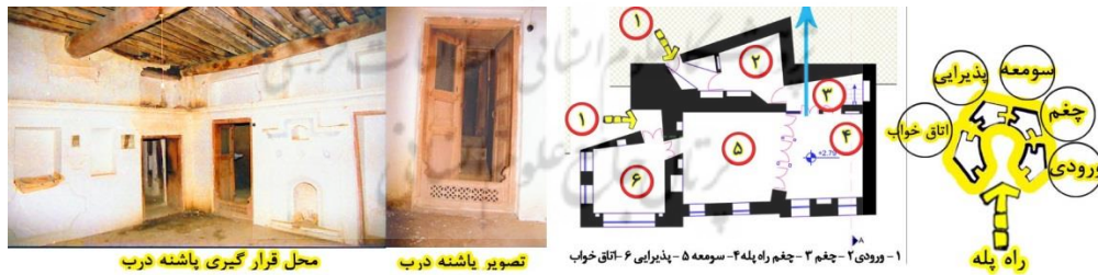
شکل ۲۳. قرارگیری پاشنه درب ابنیه مسکونی سنتی ماسوله
