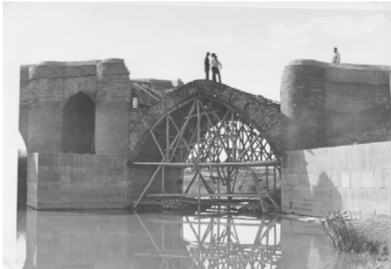
تصویر ۱۳: چشمه تاق دوم از غرب که در سال ۱۳۵۴ ه.ش. دوباره مرمت شده است (مرکز اسناد پژوهشگاه میراث فرهنگی و گردشگری، ۱۳۵۴).
