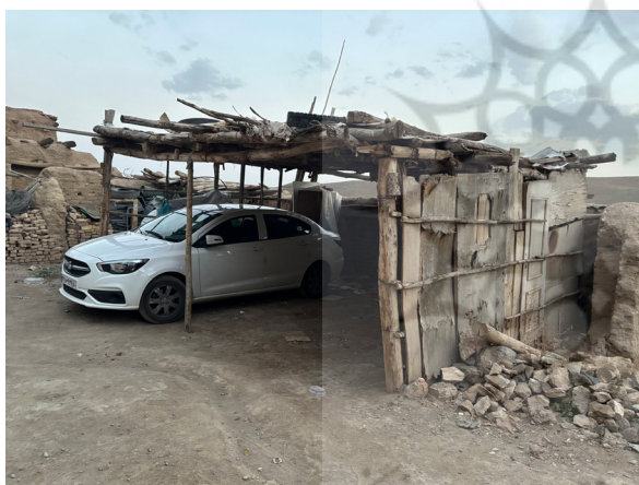
تصویر ۷. با توجه به عدم نظارت نهادهای دولتی، سازه‌ها به شکل سلیقه‌ای و متناسب با بودجه سازندگان ساخته می‌شود که بعضاً بافتی ناپایدار دارند عکس: صبا میرزاحسین، بهار ۱۴۰۴.
