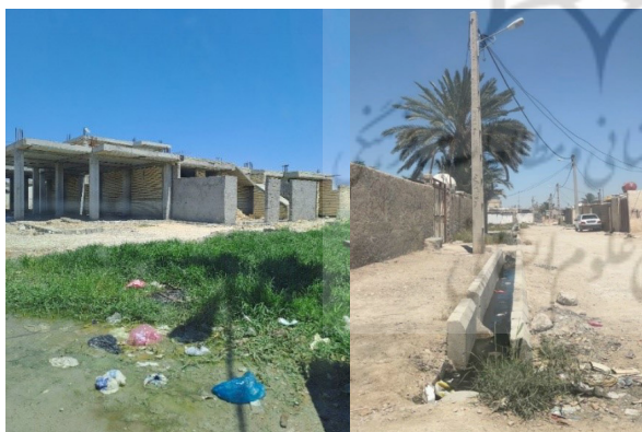
تصویر ۱. محلہ، ساختمان نیمہ کارہ بنیاد مسکن، جمع آوری نامناسب زبالہ، زیر ساخت زیر بنای، و رہنمای نامناسب. عکس: نگارندگان، ۱۴۰۳.
