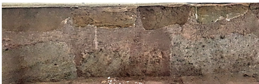
شکل ۴. پوسته پوسته شدن سطح سنگ‌های ازاره ایوان وجه جنوب شرقی بنای گنبد سلطانیه.
