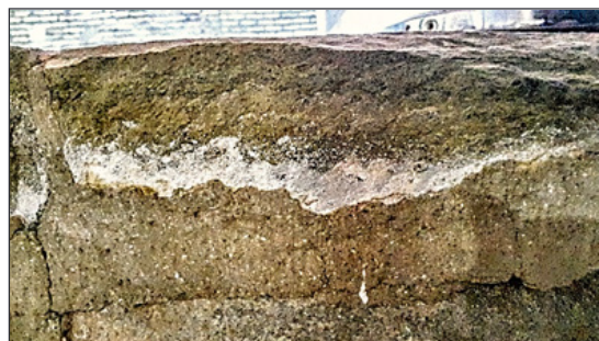
شکل ۲. حضور نمک‌ها موجب بد نما شدن ظاهر سنگ‌ها و سست شدن ساختار سنگ و ملات بین سنگ‌ها شده است.
