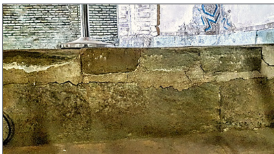
شکل ۲. حضور نمک‌ها موجب بد نما شدن ظاهر سنگ‌ها و سست شدن ساختار سنگ و ملات بین سنگ‌ها شده است.
