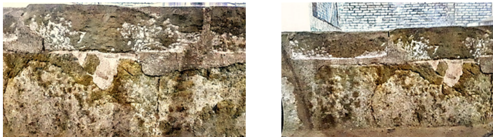
شکل ۵. پدید آمدن شرایط تبخیر و تشکیل شوره بر سطح سنگ و ملات.
