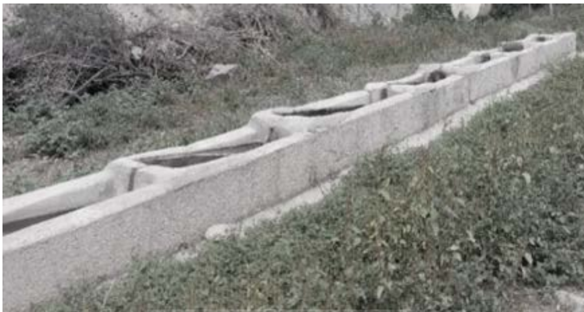
شکل ۲۱: ساخت نووه با استفاده از مصالح جدید و به صورت چندمخزنه در تلار زمستانه سامون تترستاق (نویسندگان، ۱۴۰۳). Fig. 21: Construction of a “noveh” using new materials and in a multi-chambered form in the winter Telar of Samoun-Tatarsatag (Authors, 2024).
