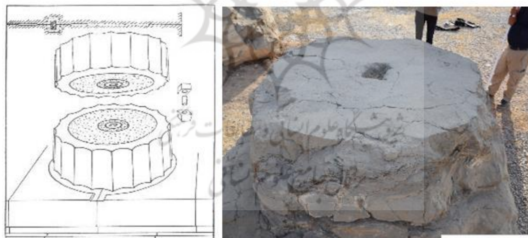
شکل ۱۳. چپ: نمونه‌ای از اتصالات استفاده شده به منظور ممانعت لغزش قطعات قلمه ستون (Nylander, 1970: 38)؛ راست: ایجاد حفره میانی در قلمه ستون و زبره تراشی اطراف آن در نمونه‌ای از پایه ستون‌های کاخ آپادانا (فدایی، ۱۴۰۱)
