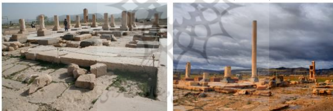
شکل ۱۵. مصالح سنگ استفاده شده در کف کاخ اختصاصی کوروش بزرگ (چپ) و کاخ بارعام (راست) شامل بلوک‌های ماسه سنگ در لایه زیرین و بلوک‌های سنگ آهک سفید در کف کاخ (بابک صدیقی، ۱۳۹۶، مرکز اسناد پایگاه میراث جهانی پاسارگاد)
