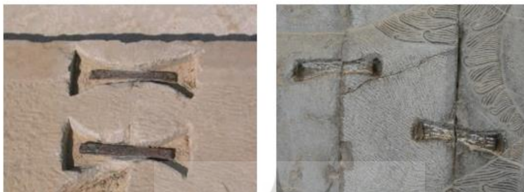
شکل ۱۲. چپ: استفاده از بست‌های فولادی موسوم به دم چلچله‌ای با پوشش سرب جهت دوخت و دوز بلوک‌های بزرگ سنگ در بنای کاخ بارعام؛ راست: وصله‌کاری قطعاتی از نقوش برجسته در تخت جمشید (مرکز اسناد پایگاه میراث جهانی تخت جمشید)
