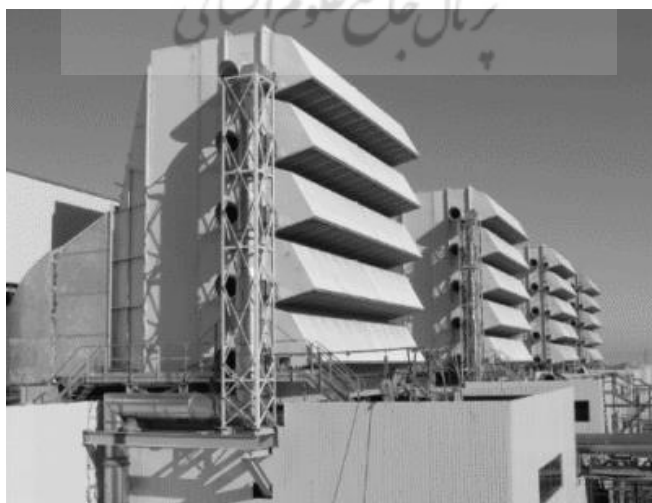
شکل ۱. سامانه ورودی هوای توربین گاز V94.2
