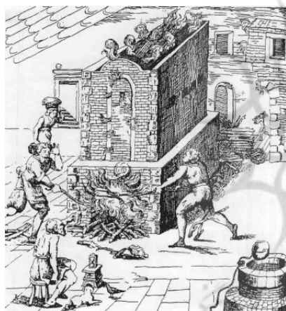
تصویر ۱۰. طراحی پیکولپاسو کوره چوب سوز در دوره رنسانس ایتالیا (رادز، ۱۳۸۲: ۵۹).
