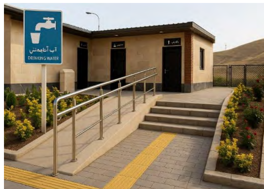
تصویر ۱۷- نمونه پیشنهادی رمپ استاندارد با عرض مناسب، دستگیره دوطرفه و کف پوش ضدلغزش جهت عبور ایمن افراد دارای ناتوانی جسمی.
