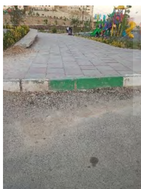
تصاویر ۲-۴-۳- ورودی پیاده‌روها و پارک فاقد رمپ؛ مانع جدی برای ورود ویلچر و کالسکه
