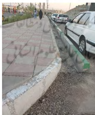
تصاویر ۲-۴-۳- ورودی پیاده‌روها و پارک فاقد رمپ؛ مانع جدی برای ورود ویلچر و کالسکه
