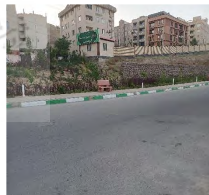
تصاویر ۲-۴-۳- ورودی پیاده‌روها و پارک فاقد رمپ؛ مانع جدی برای ورود ویلچر و کالسکه
