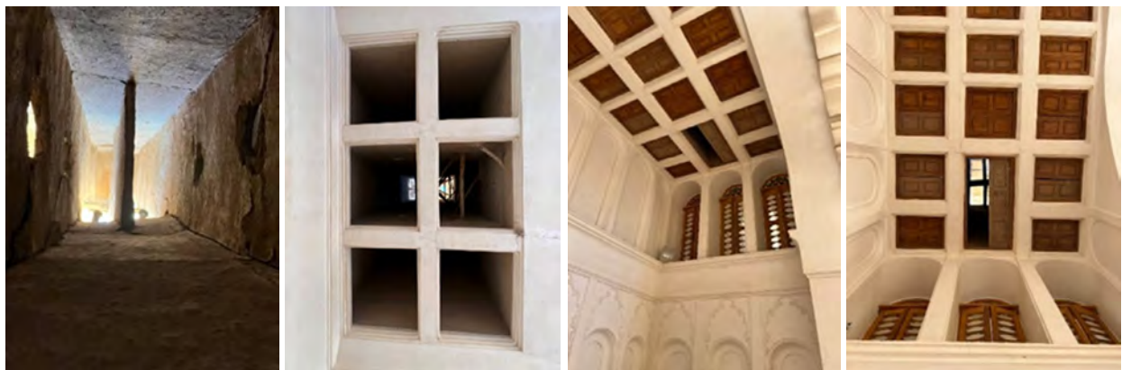
شکل ۳. تیغه های بادگیر خانه آقازاده Figure 3. Blades of the Windcatcher in the Aghazadeh House
