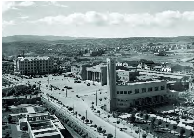
شکل ۴. ایستگاه راه‌آهن آنکارا؛ ترکیه - (مأخذ: عربانی، مقدس‌نژاد، ۱۳۹۳)
