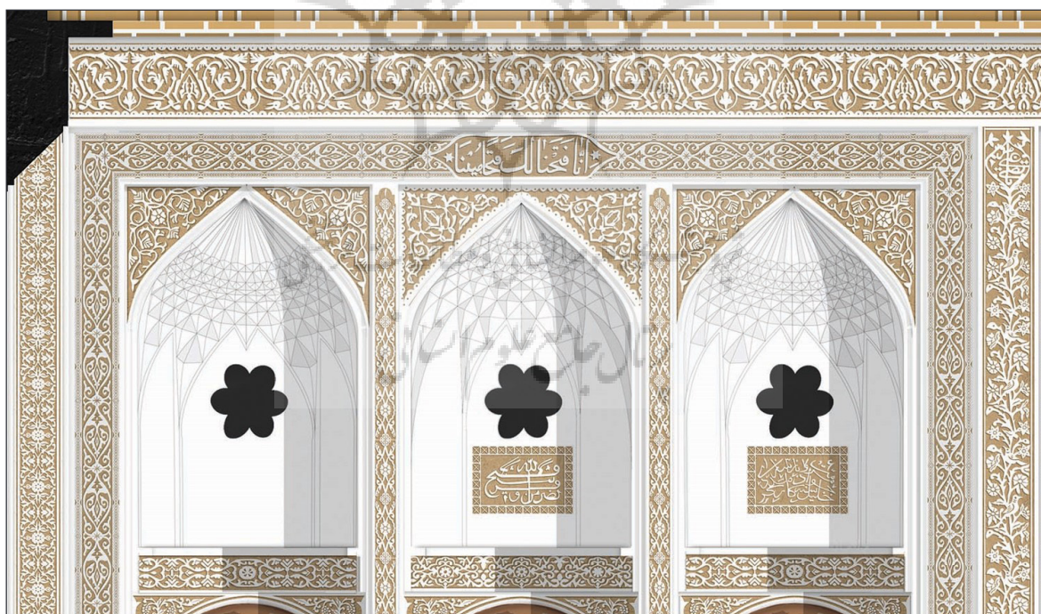
شکل ۵. بزرگنمایی تزئینات نمای حیاط.
