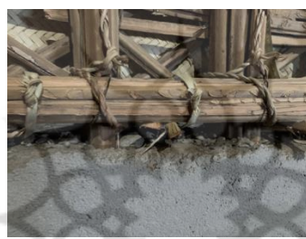
شکل ۳. نحوه استقرار شاک در داخل دیوار سیمان
