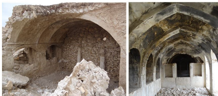
تصویر ۶. نمونه‌ای از سقف‌های طاق جناغی و طاق چَمَلِه‌ای (آبانباری) روستای سیف‌آباد بالایی (قدیم). مأخذ: یافته‌های پژوهش، ۱۴۰۱
