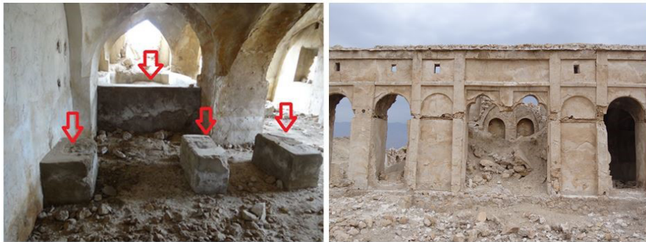
تصویر ۵. کاربرد مصالح سنگ و گچ و سیمان در ساخت خانه‌های متعلق به دوران پهلوی دوم. مأخذ: یافته‌های پژوهش، ۱۴۰۱
