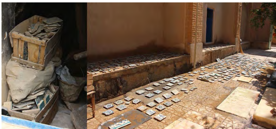
تصویر ۱۲: بیرون آوردن کاشی‌های محفوظ در یکی از حجره‌های امامزاده و شست‌وشو و دسته‌بندی آن‌ها
