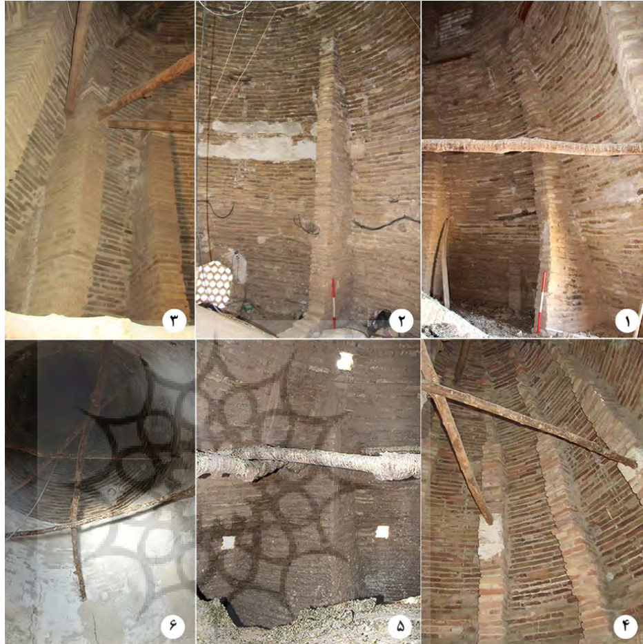
تصویر ۳: تصاویر فضای میان دو پوسته گنبدهای مطالعه شده: ۱. گنبد میرنشانه؛ ۲. گنبد سلطان امیراحمد؛ ۳. گنبد پنجه‌شاه؛ ۴. گنبد سلطان عطابخش؛ ۵. گنبد چهل تن؛ ۶. گنبد شاه یلان
