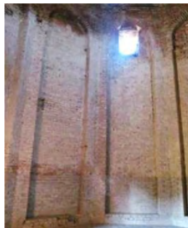
تصویر ۵. نمای داخلی دیوارهای فاقد تزئین برج مدور مراغه.
