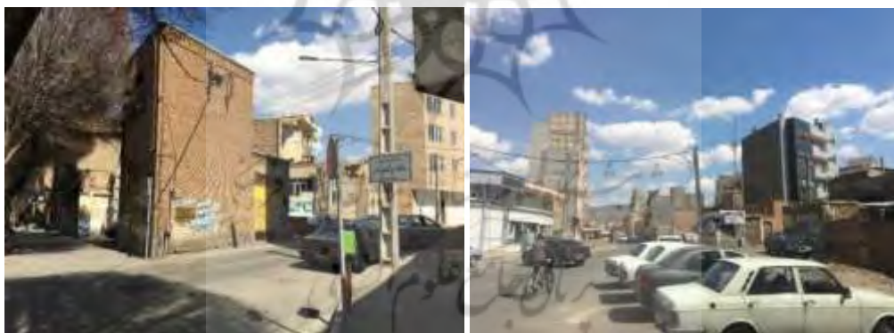
شکل ۳. عدم مطابقت ساختمان‌های قدیمی و نوساز (محله منجم)
