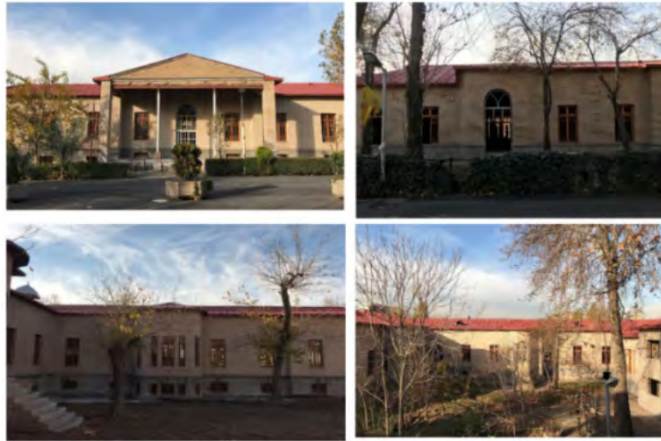
شکل ۲. نماهایی از ساختمان دانشکده معماری و شهرسازی دانشگاه هنر در پردیس باغ ملی تهران منبع: برگرفته از نارنجی، ۱۳۹۸
