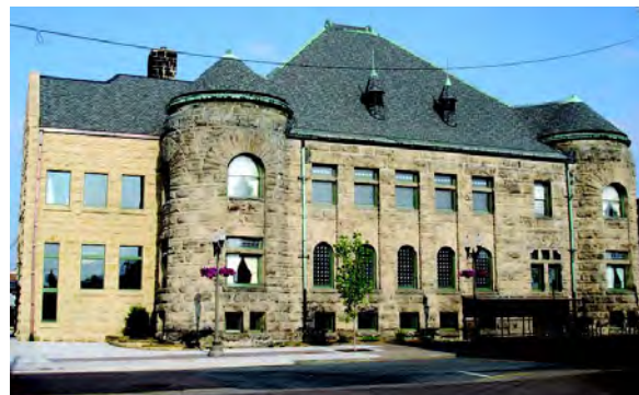
تصویر ۱۱- فضای پلکان و آسانسور (بخش الحاقی سمت چپ) که ضمن توان بخشی بنای اصلی، به پشت بنای تاریخی افزوده می‌شود با سنگ‌های ناصاف و بازتقوای ساده به صورت سازگار و تابعی از بنای اصلی معرفی می‌گردد. مأخذ: (Grimmer & Weeks, 1986).
