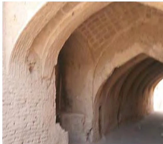
تصویر ۴. تعبیه ورودی در زیر ساباط و ایجاد حریم در فضای عمومی گذر
