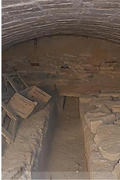
Abb. 7: Die Verbindung des Qanats mit dem Nachbarhaus
