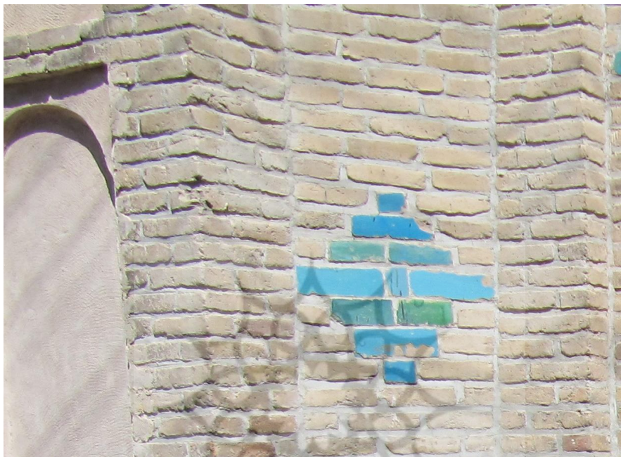
تصویر شماره ۱۰ - نمونه ای از آجرهای لعاب دار در نمای مسجد قله (بیلانکوه)
