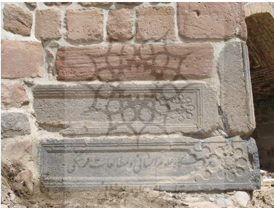
تصویر شماره ۷ - سنگ مزارات بیلانکوه در پایه پل بیلانکوه
