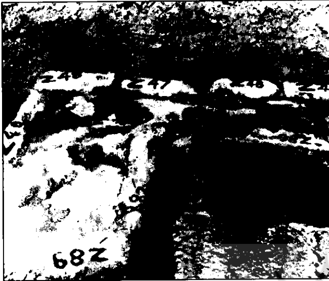
تصویر شماره ۲۴- چگونگی کد نویسی ( رنگ ، مشکی برای سنگهای نمای بیرونی و رنگ قرمز برای سنگهای نمای داخلی ). ضمناً حروف به کار برده شده نیز دارای علامت خاص هستند .
