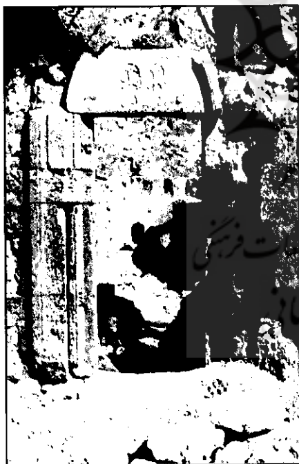
تصویر شماره ۱۸- نمای بیرونی سردر ورودی بنا هنگام پیاده کردن سنگهای قوس، نقش دو صلیب، بر روی سنگ لنتو دیده می شود.
