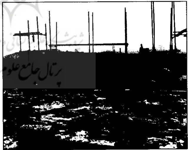
تصویر شماره ۵۳- فرم کار گذاشتن سنگها و ایجاد داربست فلزی و نصب بالابر دستی به منظور حمل و نقل مصالح به پای کار.
